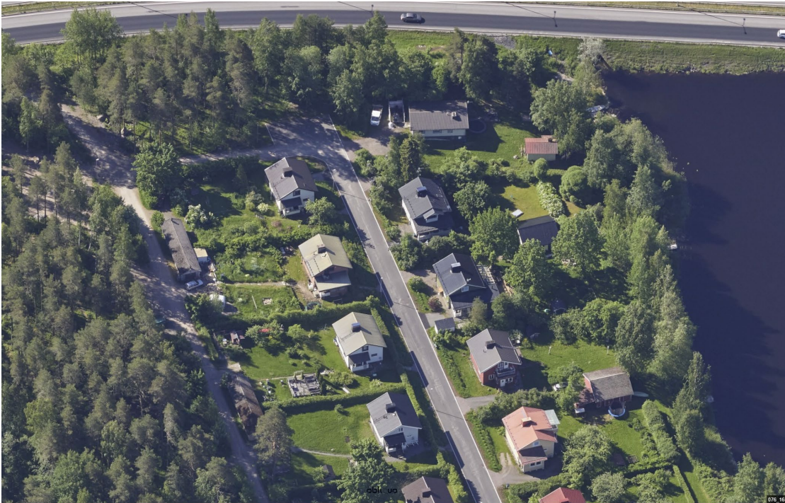
Niitynpääntien eteläosaa. Moottoritie, jossa ei ole melusuojuksia, kuvan ylälaudassa.
